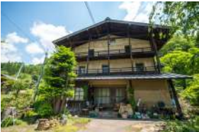
VE-09 六合エリア：湯本家 (現在耐震工事中/2025では会場利用なし)
